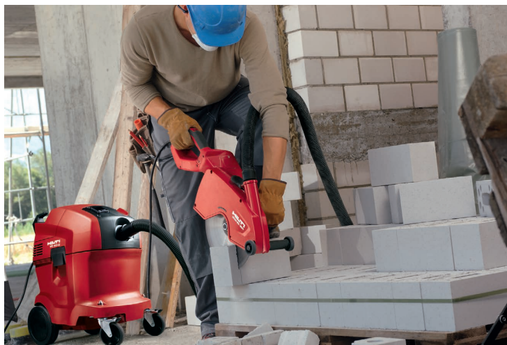
DCH 230は切り込み深さが85mmあります。両側から切り込むことにより最大170mm厚のコンクリートの開口作業が可能。
