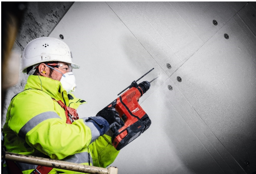
プレハブ耐火ボードの留付け
