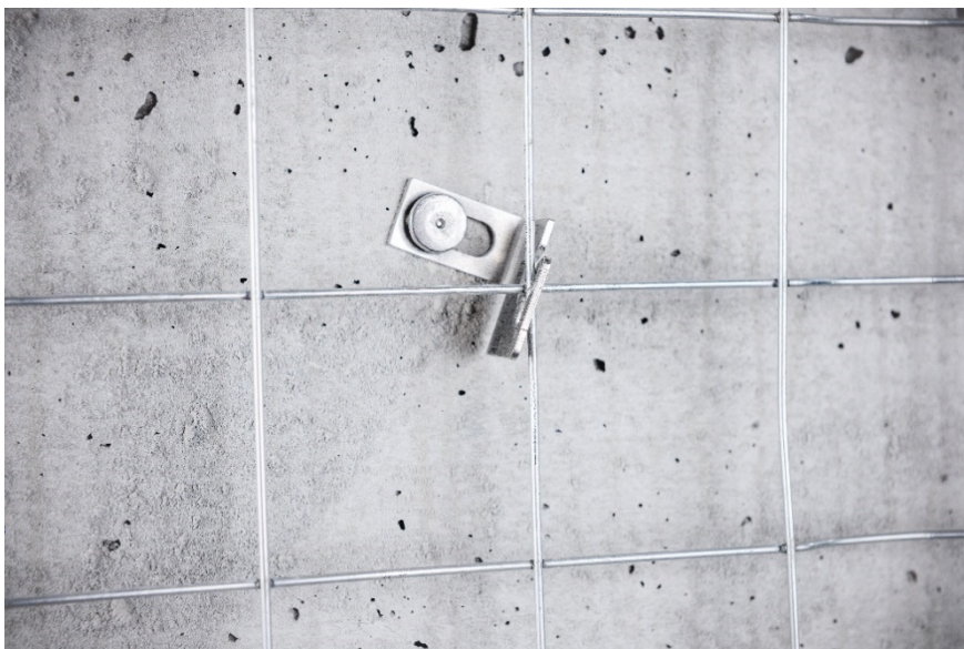
耐火モルタル用軽量ワイヤーメッシュ筋留付け
