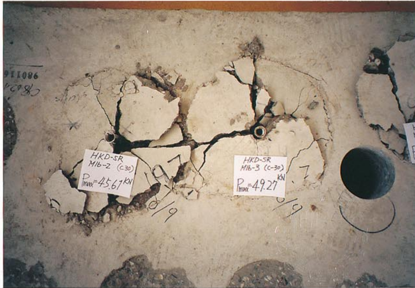
写真-9 試験項目:引張試験 \sigma_c (N/mm 2 ): 28.4 試験体記号: HKD-SR M16×65-2, 3 [試験体の状況] 複合破壊
