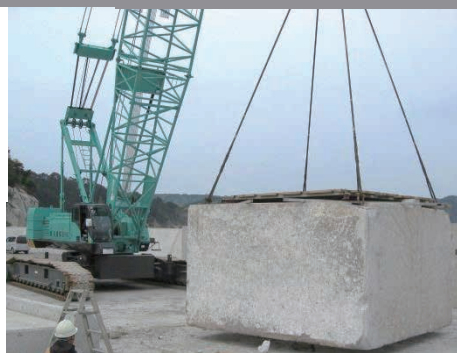
ブロック吊上げ工事
