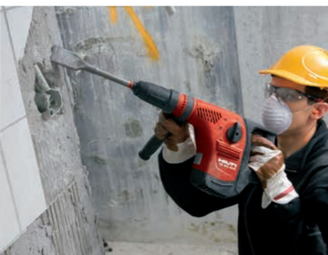
不陸調整などの正確なハツリ作業やノロはがしに
