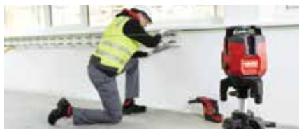
ドア、窓、機器設備等のレベル出し
