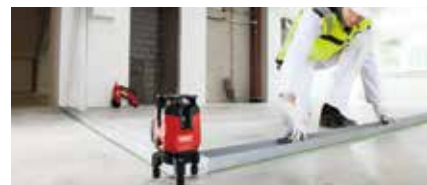
間仕切り壁の設置
