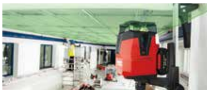
吊り天井の設置
