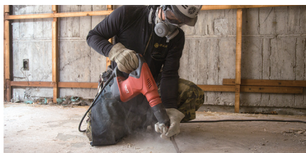
コンクリートの破壊、整形
